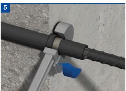
Inserte la contratuerca en el cilindro roscado del componente macho para fijar la sección hembra. Utilice una llave dinamométrica para aplicar a la contratuerca el par de apriete correcto. Los pares de apriete correctos están representados en la tabla.
