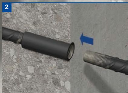
Con el hormigón fraguado y listo para colocar las extensiones, retire la tapa de plástico del extremo del manguito. Coloque la barra de continuación en el manguito y gire la barra para insertarla en el manguito.
