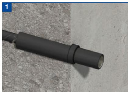
La sección hembra del manguito posicional suele ir embutida en el hormigón. El instalador debe extremar la precaución para proteger las partes de rosca internas y evitar la entrada de hormigón. Antes de continuar ampliando el fraguado, se puede colocar el extremo macho y atornillar en su lugar con la contratuerca.
